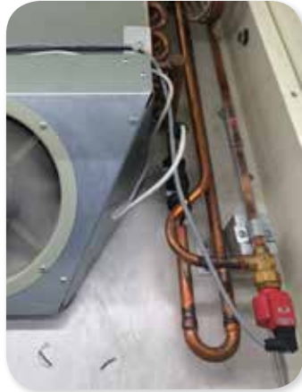
用于蒸发器的电子膨胀阀
