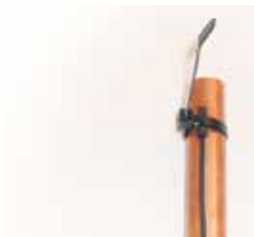
1) 将线缆缠绕的管道上并缚住;
