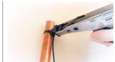
3) 用工具拉紧然后剪断绑线;
