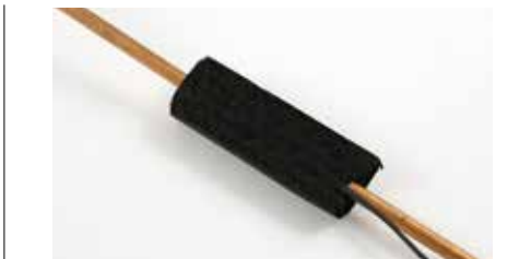
5) 对传感器包裹热绝缘胶至少10 cm长, 裹住传感器盖帽和剪断的线缆。
