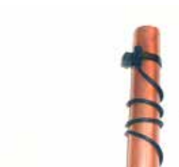
4) 将线缆缠绕的管道上两圈;
