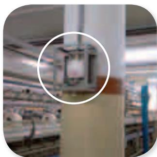
sonda di umidità installata a parete
