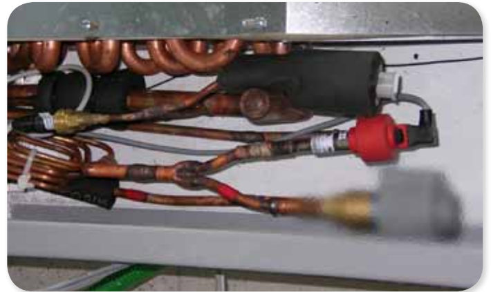
E2V膨張弁とパルス幅変調PWM膨張弁の並列設置
