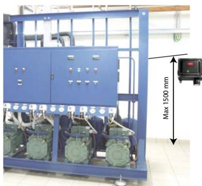
Für Kältemittel: R-717 (NH<sub>3</sub>) - R-1150 (ETHYLENE)
