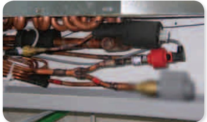
Parallelinstallation der E<sup>2</sup>V- und PWM-Ventile
