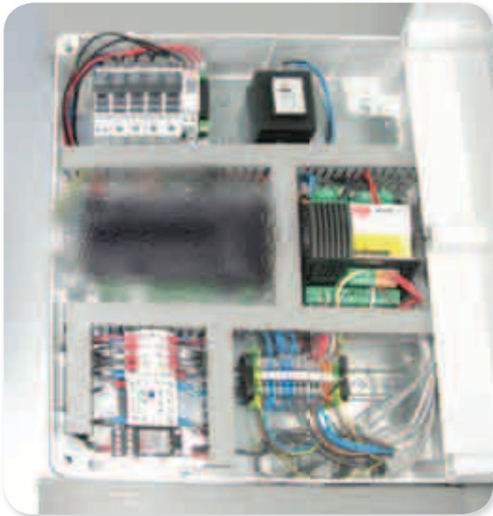
*Der Schaltschrank wurde so umdisponiert, dass eine Umschaltung von der PWM- auf die E<sup>2</sup>V-Technologie manuell oder über den PlantVisorPRO-Supervisor erfolgen konnte*
