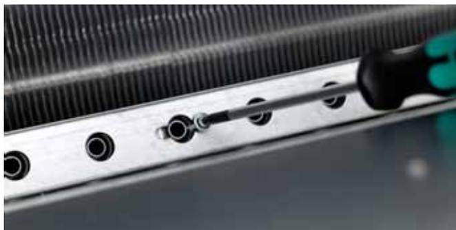
Рис. 7 Конфигурация форсунок L (низкий расход воздуха)
