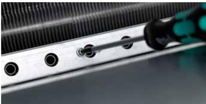
Рис. 8. Конфигурация форсунок M (средний расход воздуха)
